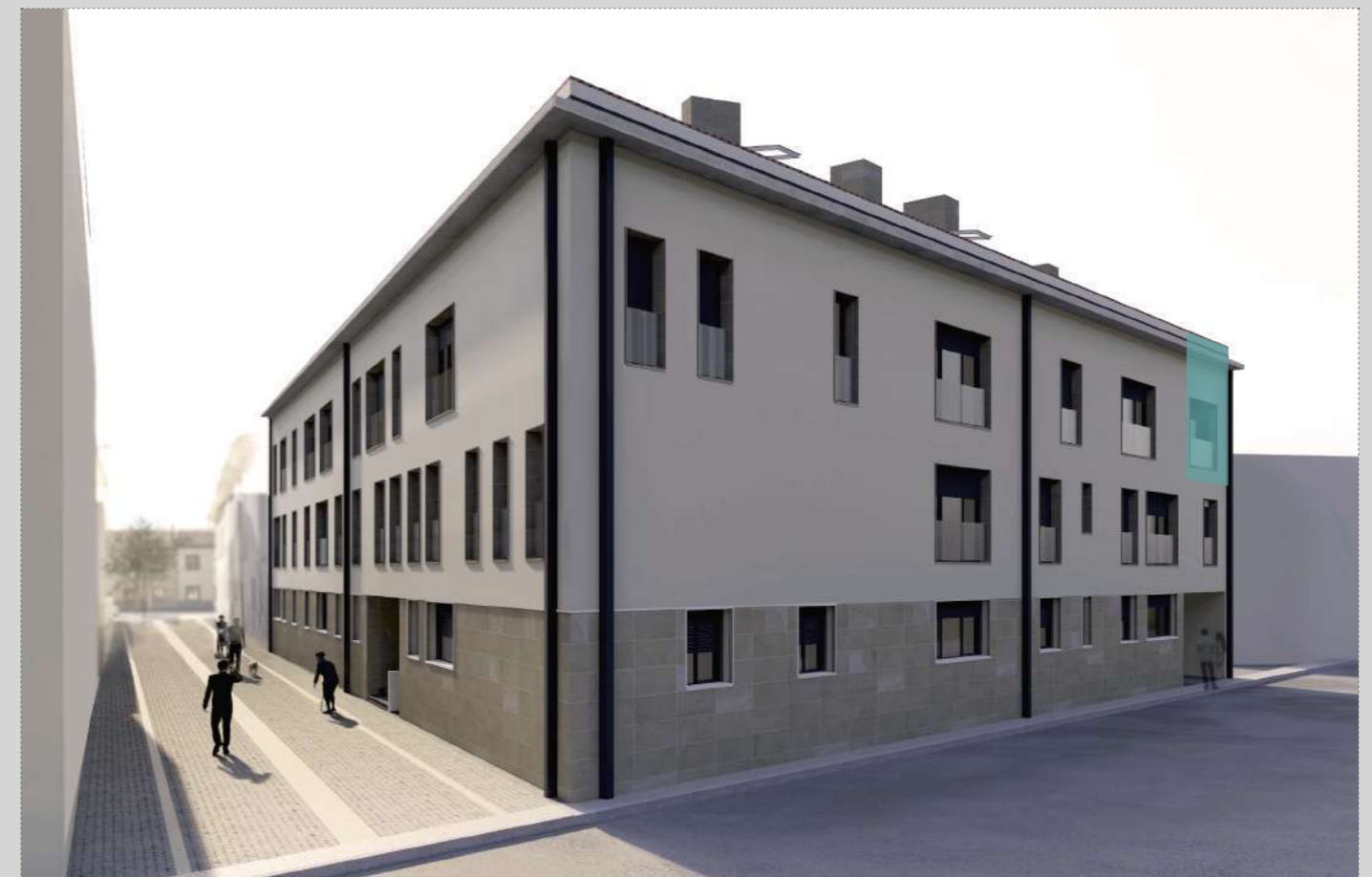
vista general ACCESO
